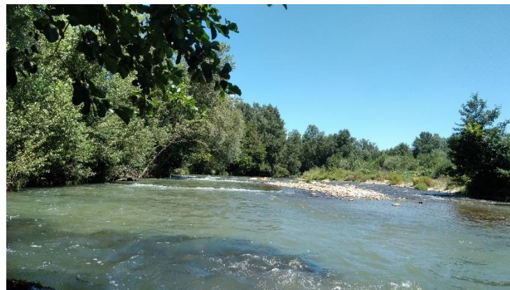
Radier Amont de la station.
