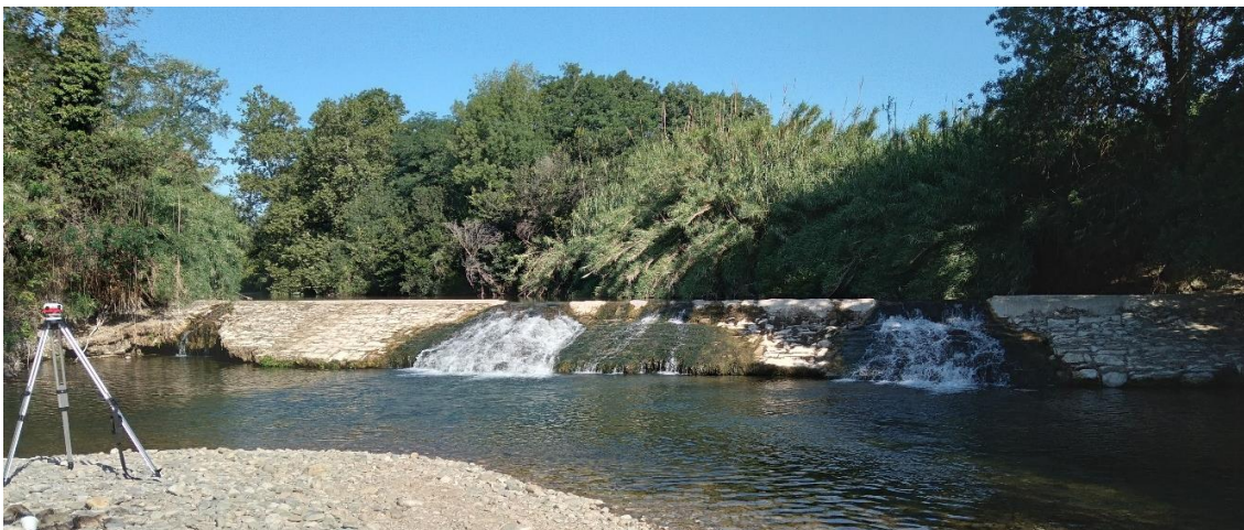
Figure 13. Photographie du barrage de Truilhas le 05 juillet 2022
