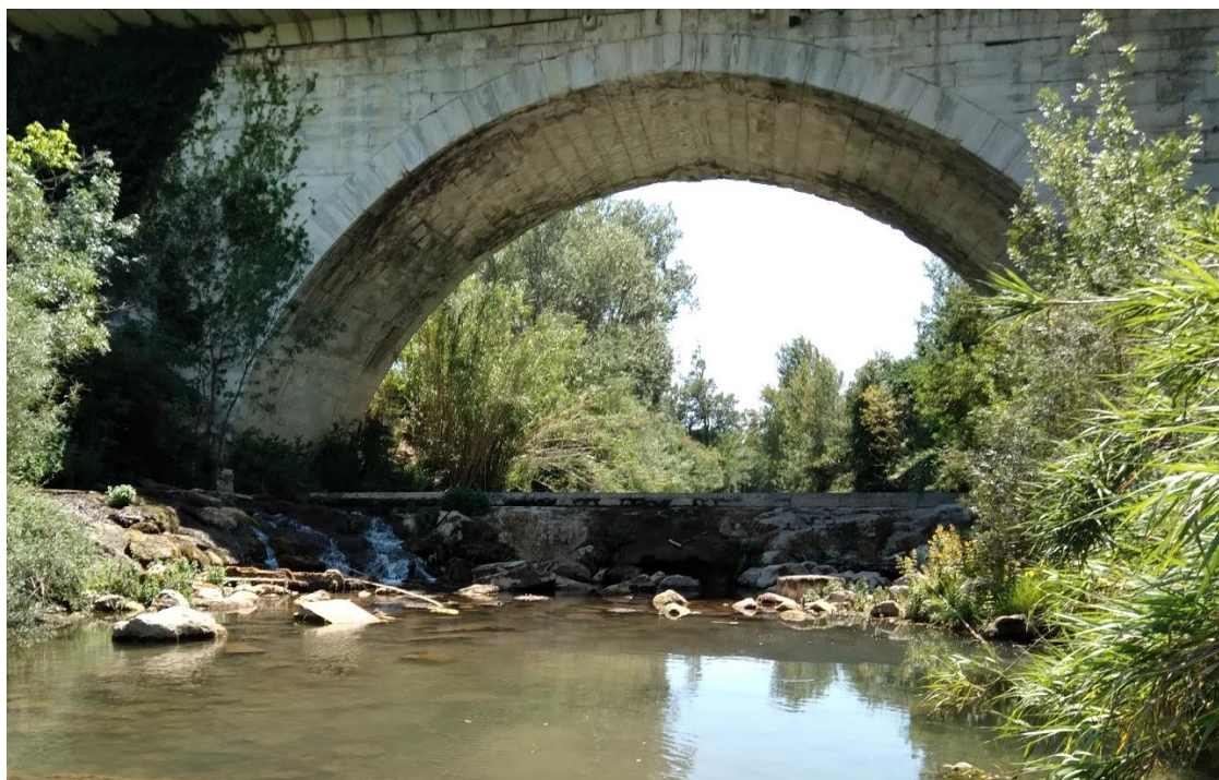
Figure 10 : Photographie du barrage du Lac le 05 juillet 2022
