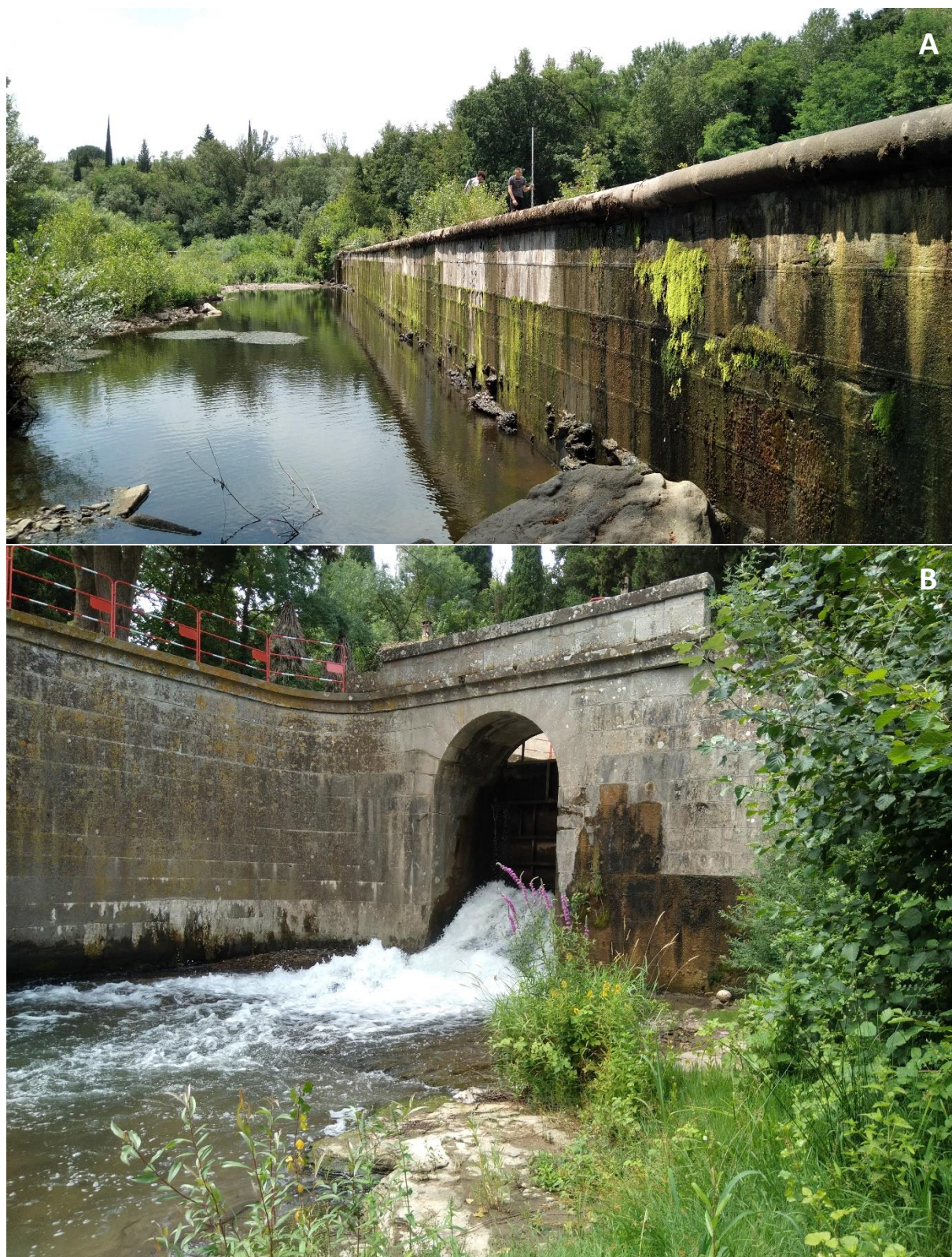
Figure 16 : Photographies du barrage VNF (A) et de la vanne en charge (B), seule exutoire de l'obstacle le 22 juin 2022
