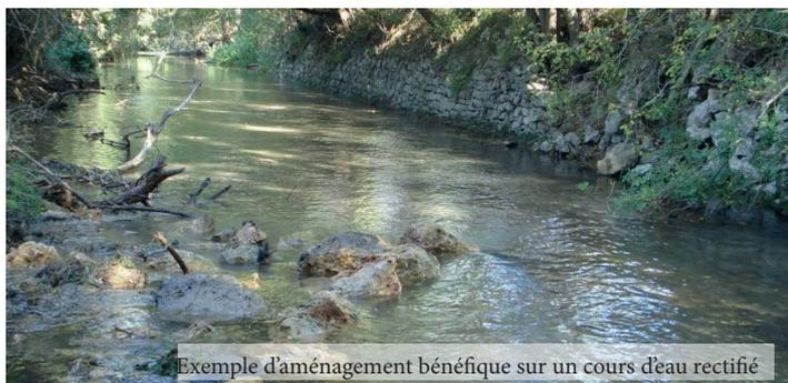
Traitement du seuil par suppression de la chute (50 à 80 cm) permettant la réduction de l'emprise du remous hydraulique en amont et l'émergence d'un radier en amont de la station.
